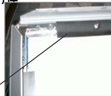
金具を取り外しLEDを交換
