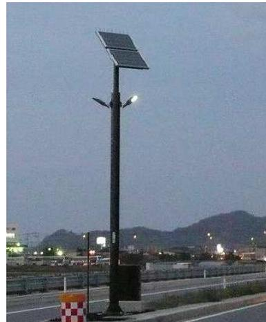
オプションにより風速計、防犯カメラ、発電表示機の搭載が可能。
